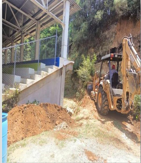
Se llevó a cabo la excavación para la reparación de la línea principal de agua potable del municipio en el Barrio de Tlacpac, así mismo se realizó la excavación para la reparación de la línea que conduce al pozo artesanal del municipio.
