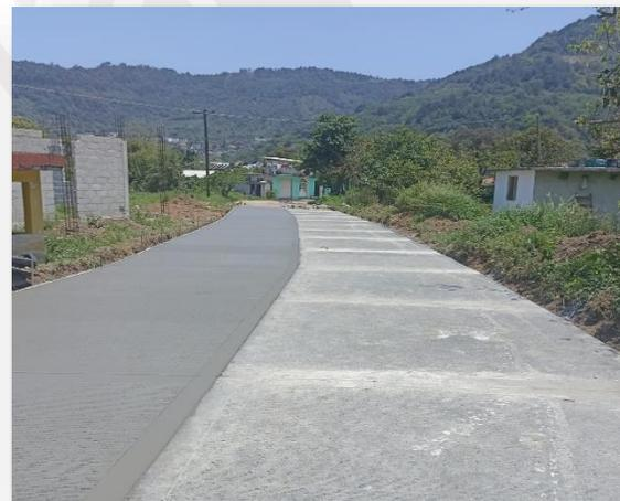
**Obra:** Pavimentación de concreto hidráulico en calle Principal para beneficiar al Barrio Lagunillas el Chico, en la localidad de San Mateo.
