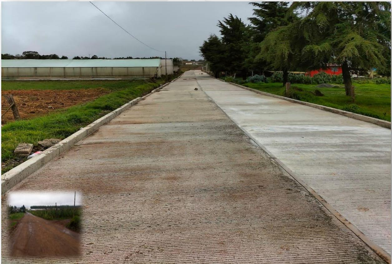
**Obra:** Pavimentación de concreto hidráulico en la calle para beneficiar a la localidad de Apapaxtla el Grande.
