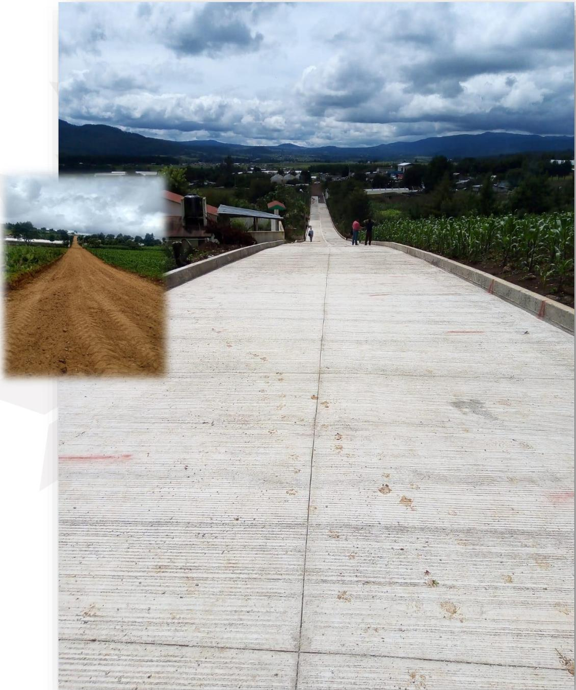
**Obra:** Pavimentación de concreto hidráulico en calle principal para beneficiar a la localidad de Coyametepec.
