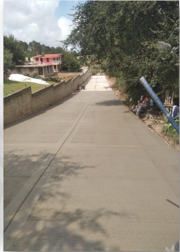
**Obra:** Pavimentación de concreto hidráulico en calle principal para beneficiar al Barrio El Hielo, localidad de Zacacuautla.
