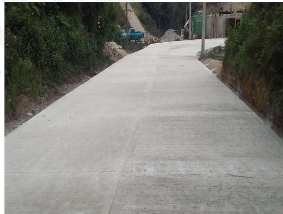
**Obra:** Pavimentación de concreto hidráulico en calle principal para beneficiar a la localidad de El Canal.
