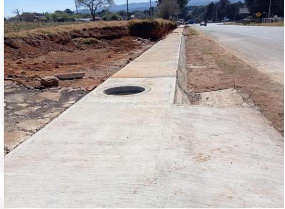
**Obra:** Construcción de cunetas Tlamimilolpa.
