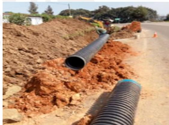
**Obra:** Construcción de red de drenaje sanitario para beneficiar al Barrio Héroes de la Revolución en la localidad de La Boveda.
