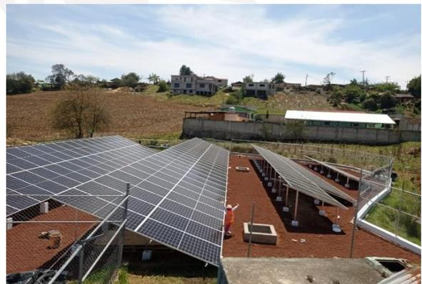
**Obra:** Ampliación de red eléctrica a base de 46 paneles solares para pozo de agua en la localidad de Los Reyes.
