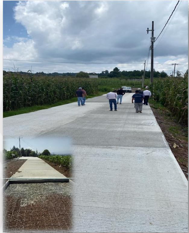
**Obra:** Pavimentación de concreto hidráulico en calle Morelos para beneficiar al barrio de Tlacpac.
