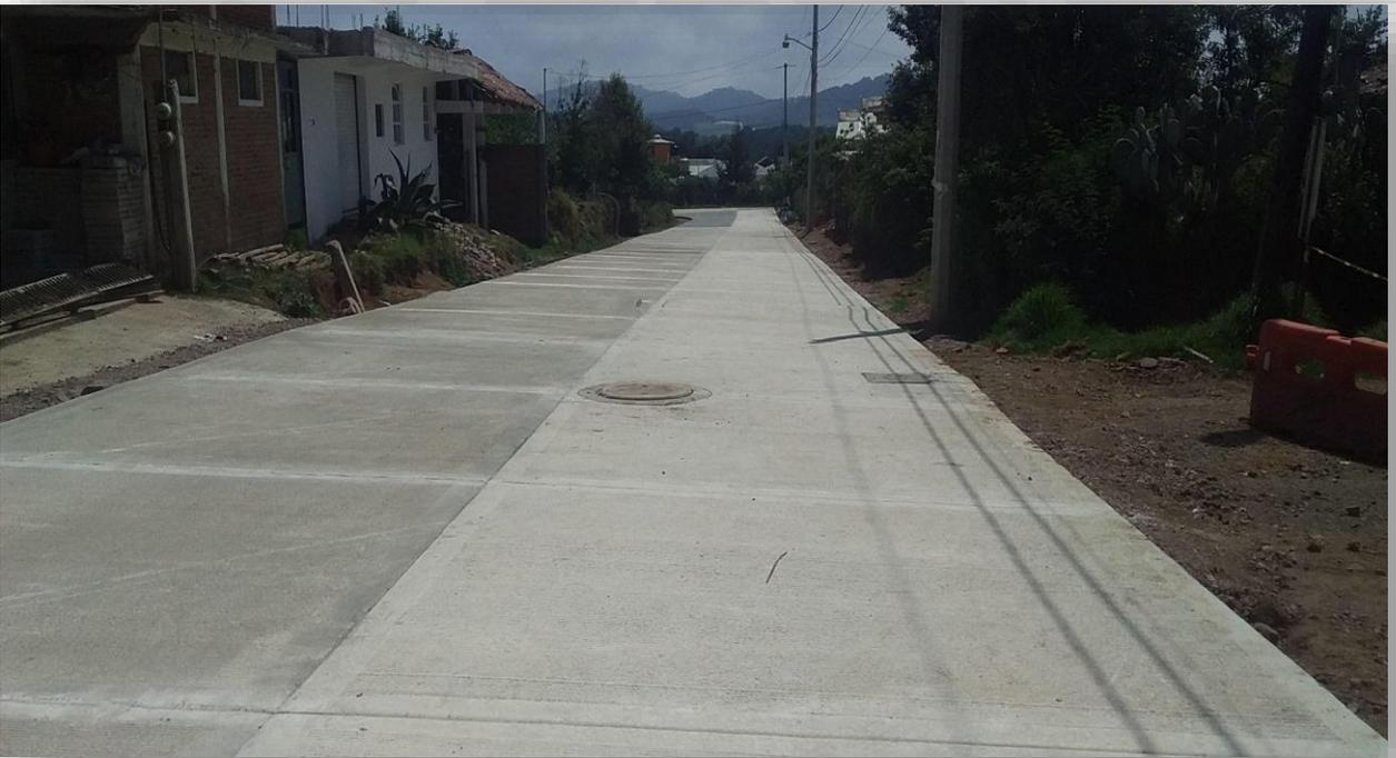
**Obra:** Pavimentación de concreto hidráulico y ciclópeo en camino las vueltas para beneficiar al Barrio Tlacpac.
