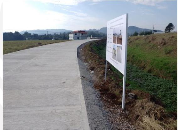
**Obra:** Pavimentación de concreto hidráulico en Barrio Cuautenco para beneficiar a la localidad de Montemar.
