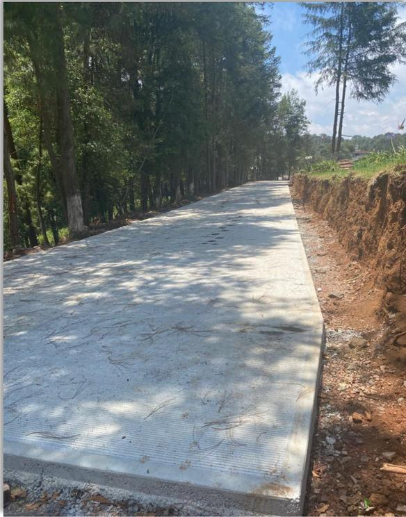
**Obra:** Pavimentación de concreto hidráulico, en calle principal para beneficiar al Barrio Tecorral en la localidad Zacacuatla.
