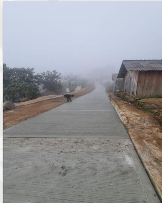
**Obra:** Pavimentación de concreto hidráulico en calle principal para beneficiar a la localidad de San Juan.
