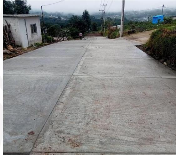
**Obra:** Pavimentación de concreto hidráulico en calle 14 de noviembre para beneficiar al barrio Tlamimilolpa.
