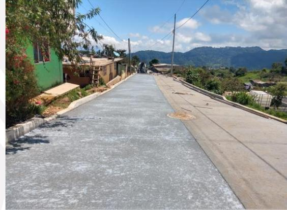
**Obra:** Pavimentación de concreto hidráulico en calle acceso para beneficiar al Barrio Tlaltenco.
